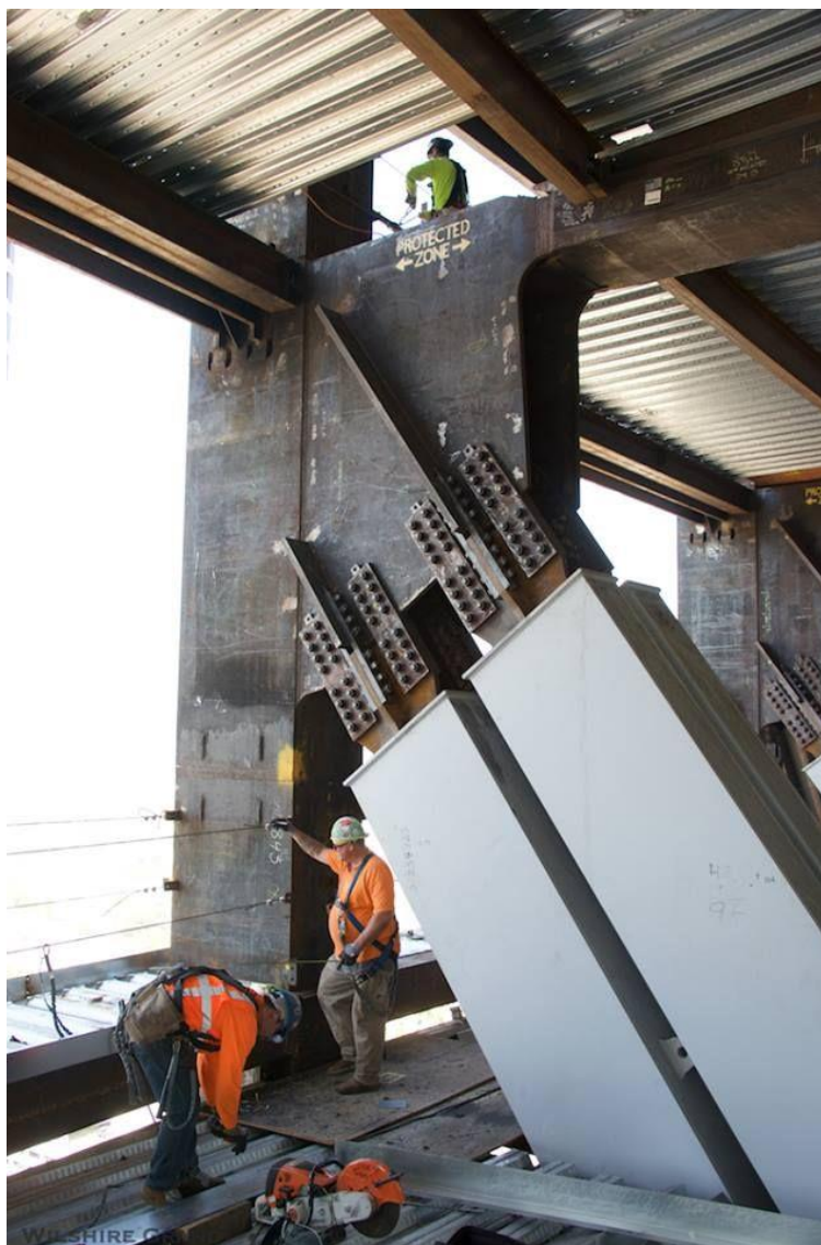
اتصال عظیم مهاربند کمانش تاب
